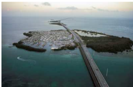
Un tratto della Route One tra Miami e Key West.
